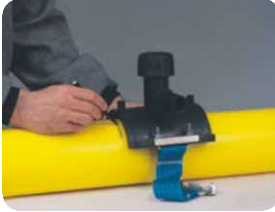
Füzyon bölgesi işaretlenmesi/ Marking of the fusion zone
