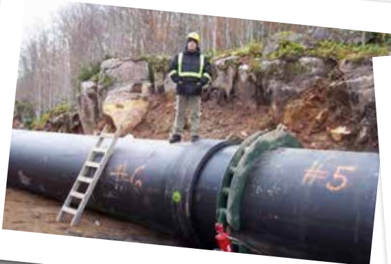
Kanada Halifax - D1600 EF Manşon Dünya'daki En Büyük Manşon! Canada Halifax - D1600 EF Coupler Application. The Biggest EF Coupler on The World!
