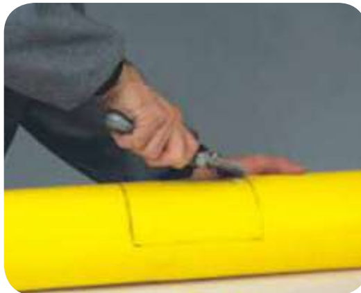
Oksitli tabakanın traşlanması/ Scraping the oxidated layer
